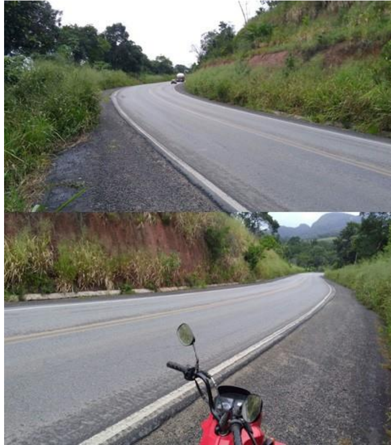
Figura 1: Foto do trecho da BR 101, km 805, sentido Itabela/ Itamaraju.
