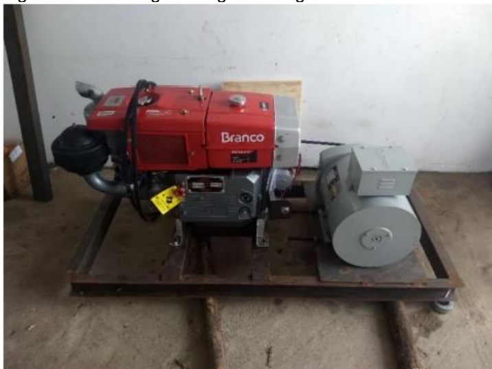
Figura 11 – Montagem do gerador agrícola.
