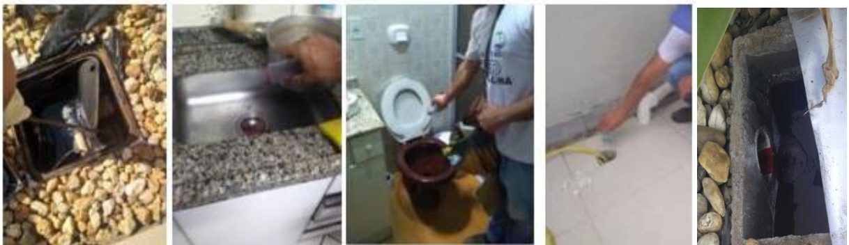
Figura 03 - Aplicação do teste com corante em pó
