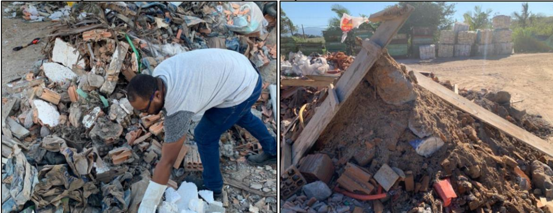
Figura 6 - À esquerda da imagem: Realização da triagem manual na primeira caçamba amostrada. À direita da imagem: Material oriundo da segunda caçamba amostrada.
