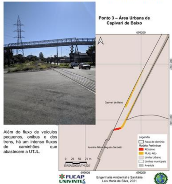
Figura 21 – Cruzamento secretaria de obras em Capivari de Baixo
