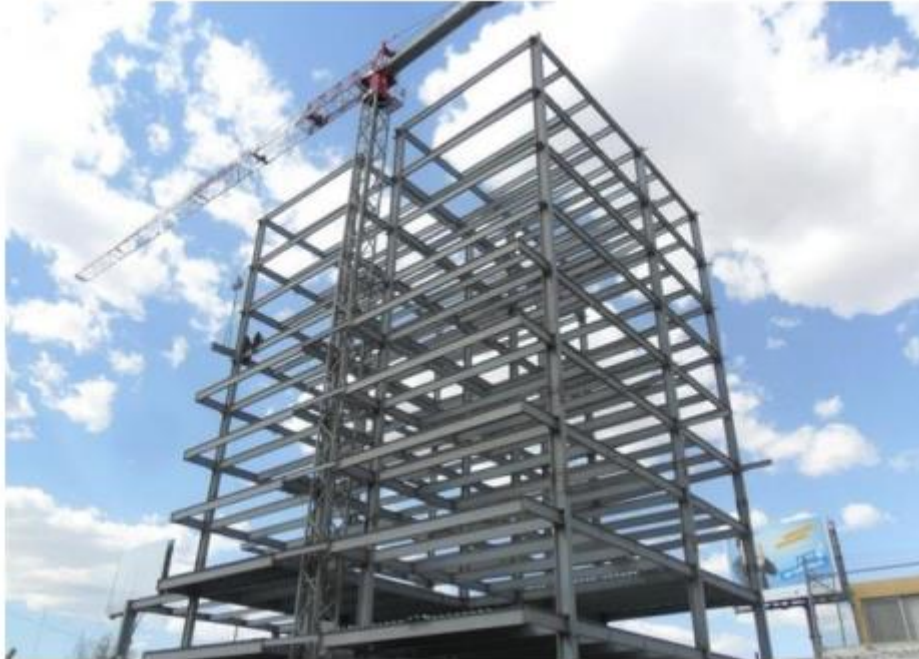
Figura 1 - Estrutura metálica utilizada para execução de prédios.
