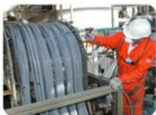
Pintura antichama de Cabos
