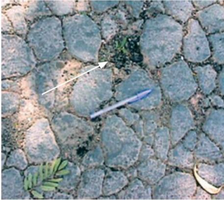
(g) Trincas tipo couro de jacaré com erosão (JE)
