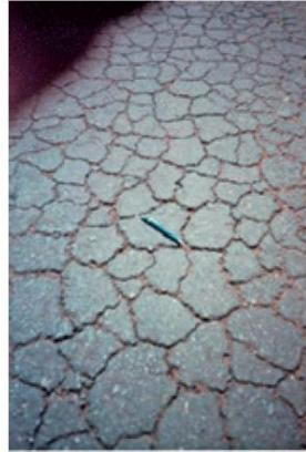
(h) Trincas tipo couro de jacaré (J)
