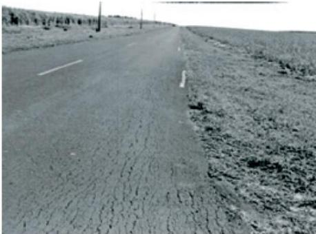
(i) Conjunto de trincas longitudinais longas
