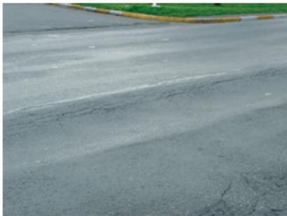
(c) Afundamento plástico nas trilhas de roda (ATP)
