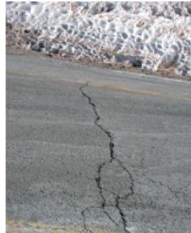
(j) Trinca de retração térmica
