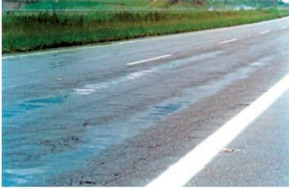
(a) Afundamento por consolidação em trilha de roda (ATC)
