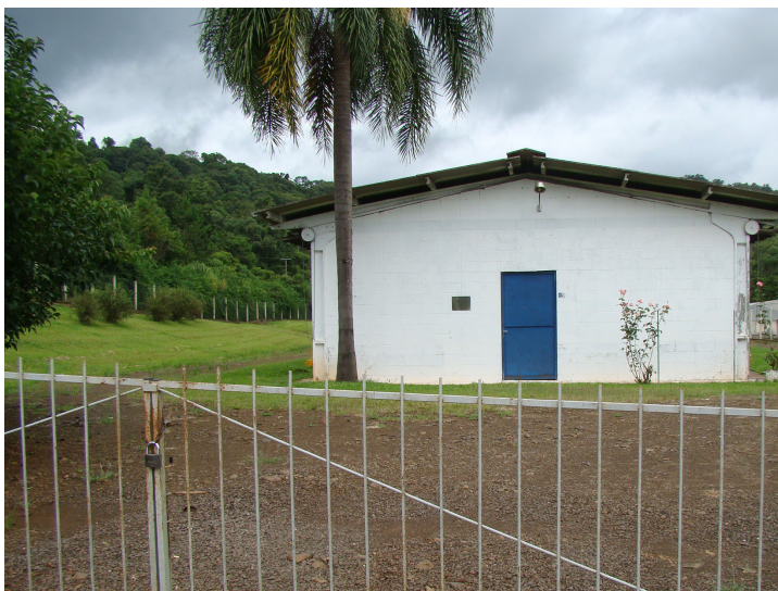
Figura 1. Portão de entrada com cadeado, instalação ao fundo e cerca de isolamento da granja visualizada nas duas laterais
