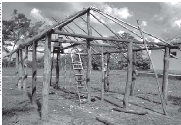
Galpão em madeira roliça em fase de construção.
