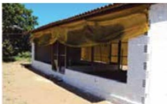
Fig. 11. Aviário de alvenaria com telhas de barro.
