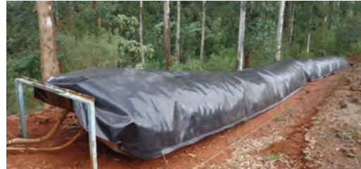
FOTO 26 | Balão pulmão com depósito de biogás, pré-gerador.
