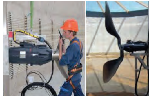
FIGURA 13 | Instalação dos agitadores submersos.
