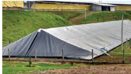
FOTO 05 | Cisterna em funcionamento.
