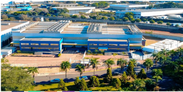
Data Center Campinas
